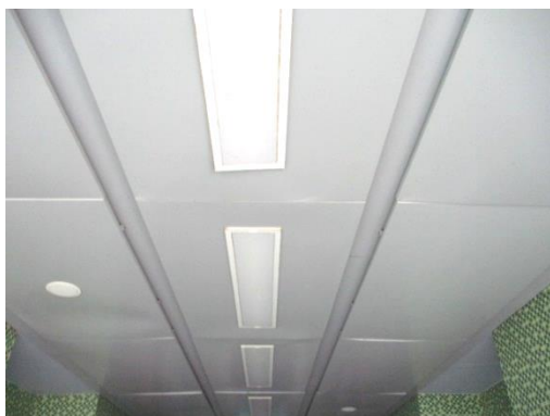
รูปที่ 2-36 ติดตั้งไฟส่องแสงสว่างบริเวณใต้สถานีและด้านข้างริมทางเท้า
