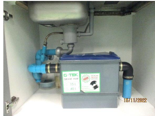
รูปที่ 2-26 (ต่อ) บำบัดน้ำเสียและบ่อดักไขมัน
