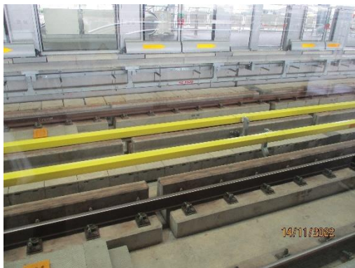
รูปที่ 2-4 หมุดยึดราง เฉพาะช่วงหมอชิต-สะพานใหม่
